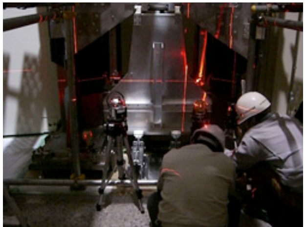
図2 据付調整中の検出器架台
