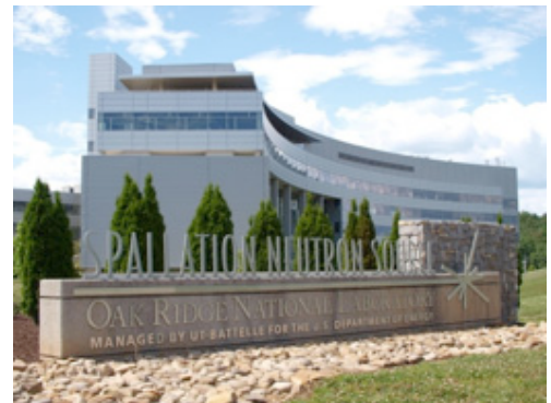
図1 ORNL内のSNS入口。写真は研究室等が入っている建物。
